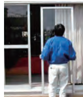
① 障子の取り外し 既存の窓枠から障子を取り外します。
