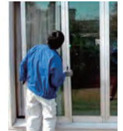
④ 障子の取り付け “エコガラス”を組み込んだ障子を既存の窓枠に戻して完成です。
