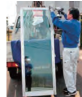
③ 組み込み “エコガラス”をサッシ枠に組み込みます。
